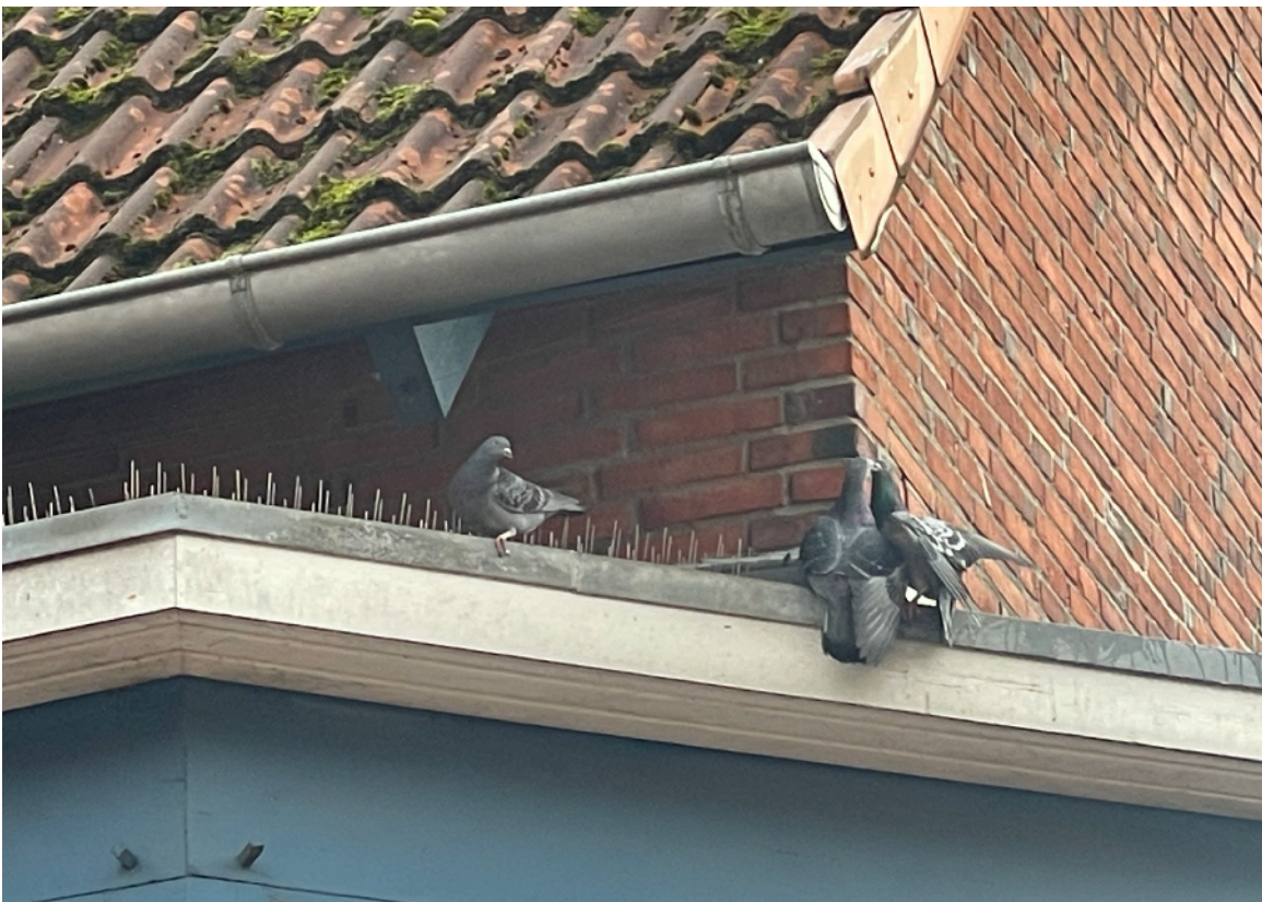
Abb.5: Brutplatz auf einem Dachvorsprung mit Abwehrspikes.
