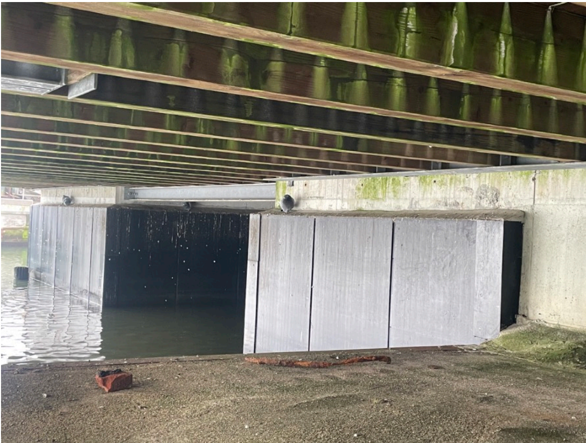
Abb.4: Geschützt unter der Siegfriedwerft ruhen gerne einige Stadtauben. Unter den Stahlträgern befinden sich mindestens drei Brutplätze.
